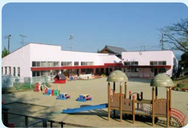
屋根改修及び外壁塗装工事が完了し美しくなった園舎
