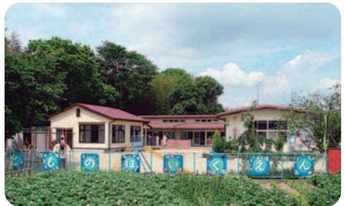
友生保育園園舎全景（左が増築部分）
