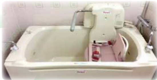
新しく設置した介護浴槽
